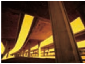
コンクリートの強度を高めています
