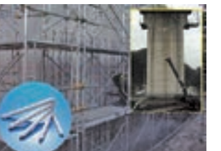
施工例（新幹線橋脚耐震補強工事）
