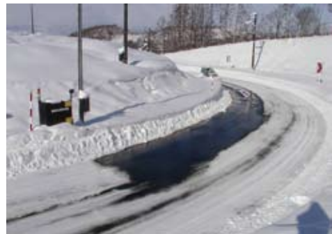
カマグ®は、道路の凍結防止に大きな効果を発揮しています。
