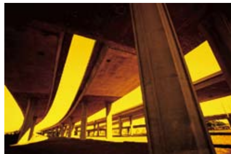
コンクリートの強度を高めています。
