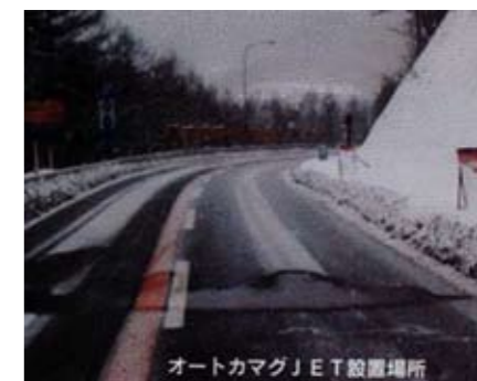
オートカマグ®ET設置場所
