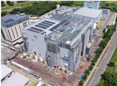
製造棟(建設中)
