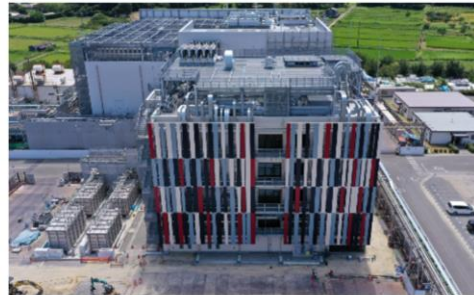
品質管理棟(外構工事中)
