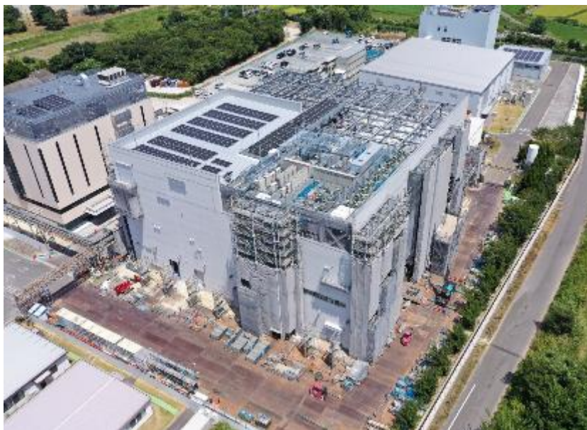
製造棟(建設中)
