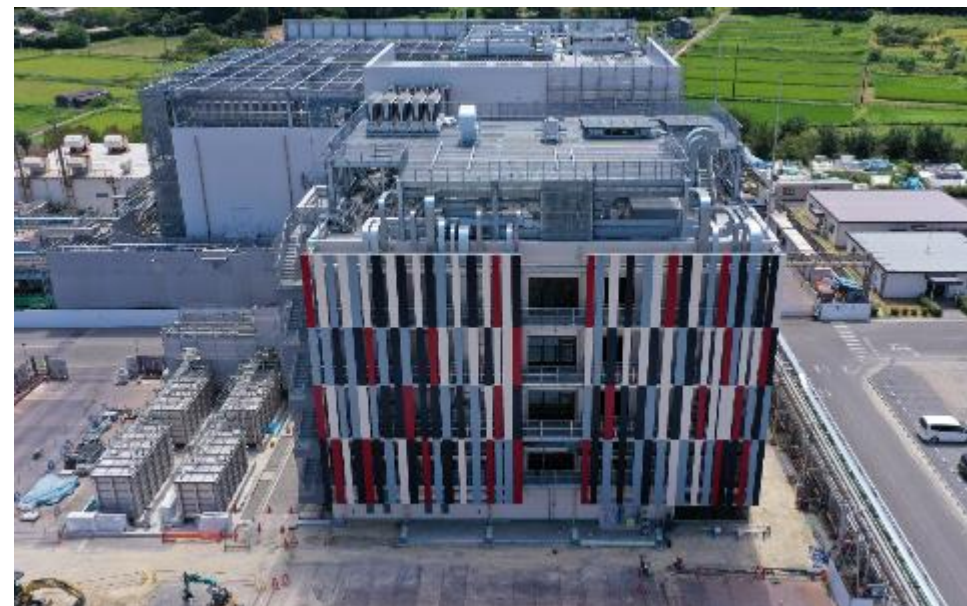
品質管理棟(外構工事中)
