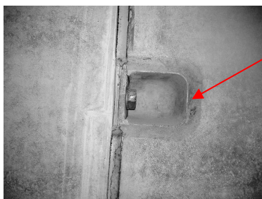
例: シールドトンネルのセグメント締結ボルト
