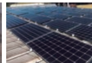
日油技研工業(株) 太陽光発電パネル
