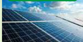
太陽光パネル設置（日油技研工業㈱）
