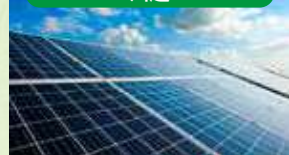
太陽光パネル設置（日油技研工業㈱）
