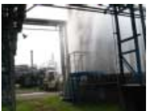
千鳥工場の防災訓練風景 (危険物貯槽ウォーターカーテン 作動確認の様子)
