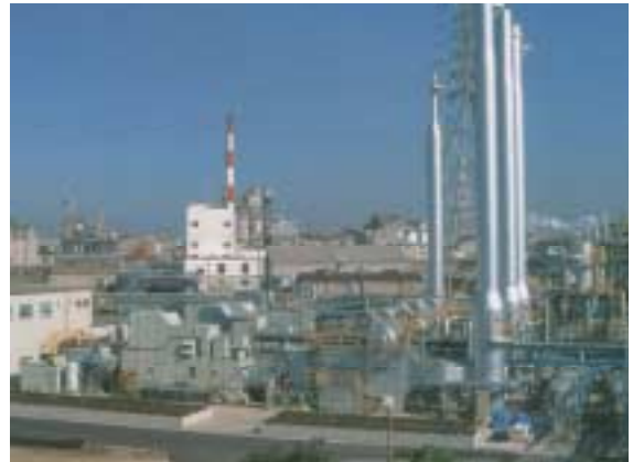
尼崎工場コジェネレーションシステム (尼崎ユーティリティサービス)
