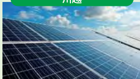
太陽光パネル設置（日油技研工業株）
