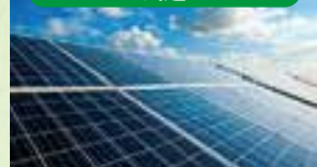
太陽光パネル設置（日油技研工業株）
