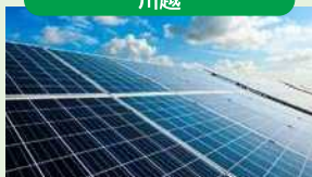
太陽光パネル設置(日油技研工業株)
