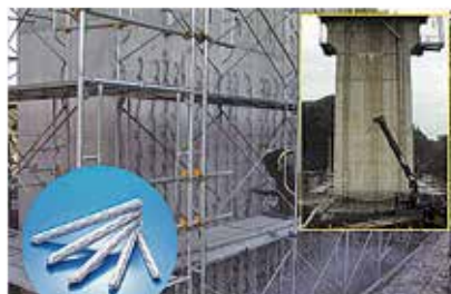
施工例（新幹線橋脚耐震補強工事）
