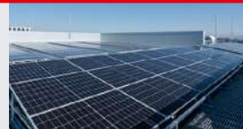
太陽光パネル設置
