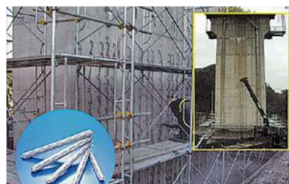
施工例（新幹線橋脚耐震補強工事）
