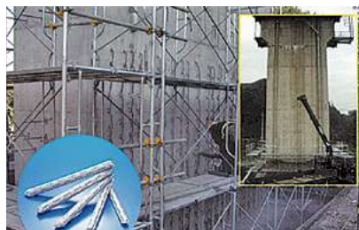
施工例（新幹線橋脚耐震補強工事）
