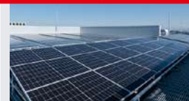
太陽光パネル設置
