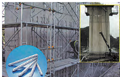
施工例（新幹線橋脚耐震補強工事）
