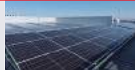
太陽光パネル設置
