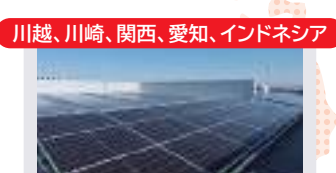
太陽光パネル設置
