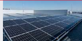
太陽光パネル設置
