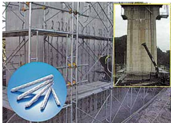
施工例(新幹線橋脚耐震補強工事)
