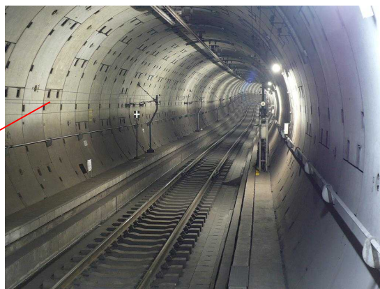
例: シールドトンネルのセグメント締結ボルト
