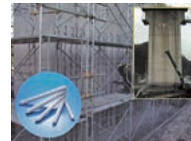
施工例（新幹線橋脚耐震補強工事）
