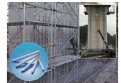
施工例（新幹線橋脚耐震補強工事）
