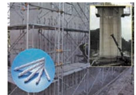
施工例（新幹線橋脚耐震補強工事）
