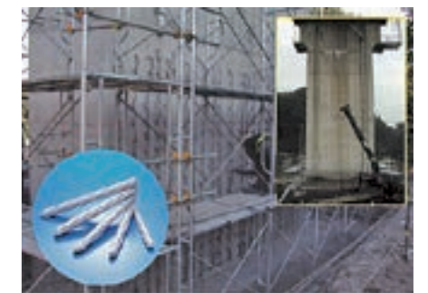
施工例（新幹線橋脚耐震補強工事）
