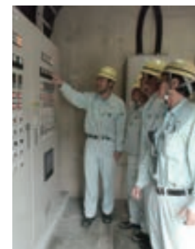
製品保管庫冷凍機取扱教育
