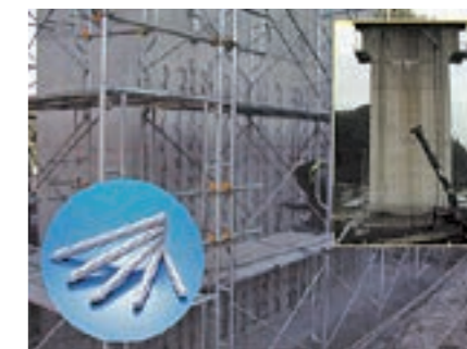
施工例（新幹線橋脚耐震補強工事）
