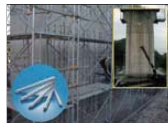
施工例 (新幹線橋脚耐震補強工事)
