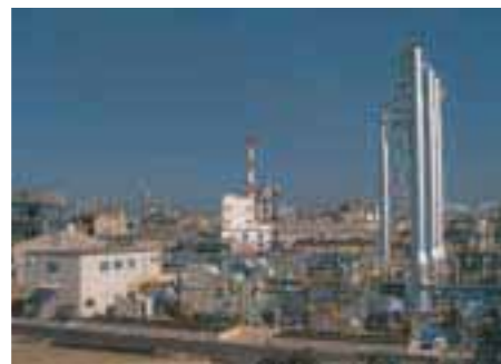
尼崎工場コージェネレーションシステム (尼崎ユーティリティーサービス)
