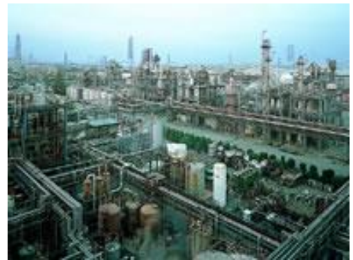
機能化学品 製造設備(尼崎)
